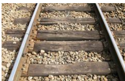
Rails courts sur traverses bois
